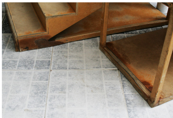
Brinquedos de sala colocados no pátio, onde a chuva e a lavagem danificaram a base das peças.
